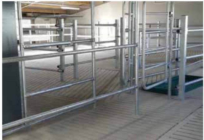
Fot. 4. Przykład zastosowania rowkowania ukośnego „jodełka”.
