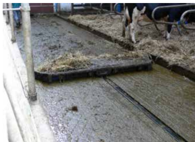
Fot. 1. Korytarz gnojowo-spacerowy o podłodze pełnej w oborze wolnostanowiskowej boksowej. Powierzchnia przygotowana przez wyciskanie rowków w świeżym betonie (fot. W.J. Wardal)
